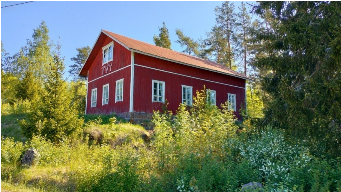
Kuva 35 Mannilan työväenyhdistyksen talo on rakennettu 1900-luvun alussa.
