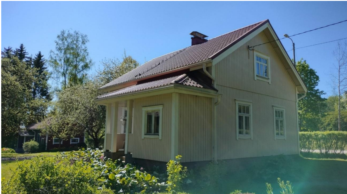
Kuva 37 Oksalan vanhempi asuinrakennus. Oksalan tilan vanhin päärakennus 1870-luvulta on purettu, mutta kuvassa oleva Mäkikylänkujan varrella sijaitseva ns. pakaririvi on säilynyt. Rakennuksen runko on pystytetty 1938 vuoden 1996 inventoinnin mukaan. Jugendvaikutteiset ikkunat ovat alkuperäiset. Rakennuksen huoneet on ryhmitelty keskusmuurin ympärille.
