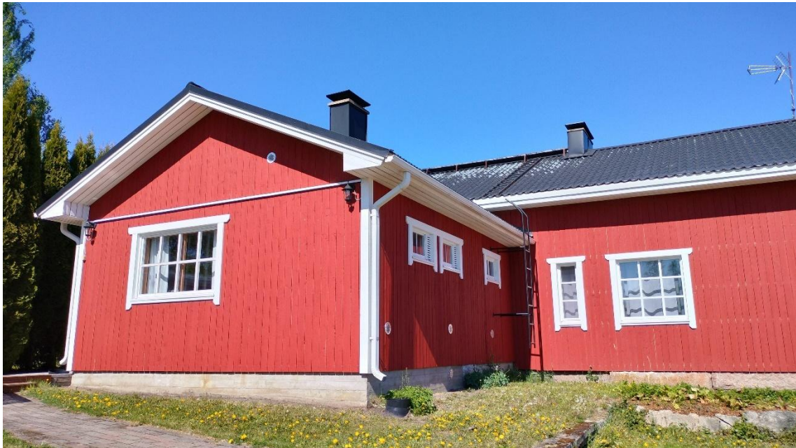
Kuva 44 Huntun päärakennuksen poikkipääty. Ylemmän kuvan poikkipääty on purettu 1960-luvulla, ja rakennettu uudelleen 1990. Poikkipäätyä on laajennettu 2000-luvulla.
