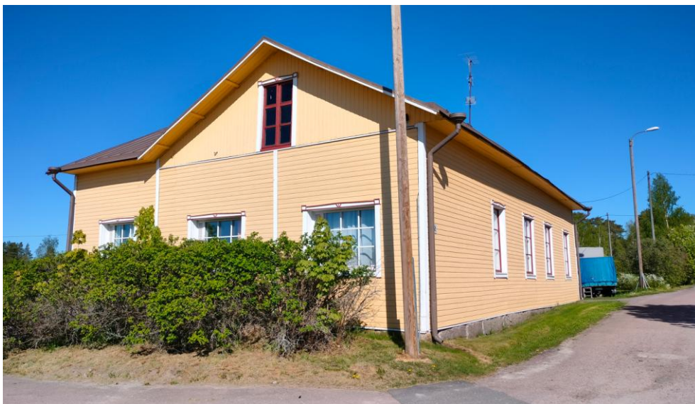
Kuva 32 Entisen osuuskaupan rakennus nykyasussaan. Rakennus on vaakavuorattu ja ainakin päädyn ikkunat on uusittu 9-ruutuisiksi ikkunoiksi. Vuoden 1996 inventoinnin mukaan rakennus on siirretty paikalle 1910-luvulla. Päädyn sisäänkäynti on laitettu umpeen. Rakennus- ja huoneistorekisterissä rakennuksen käyttötarkoitus on edelleen liikerakennus, mutta osuuskaupan toiminta rakennuksessa loppui 1970-luvun lopulla, ja kiinteistö on ollut sittemmin asuinrakennuksena.
