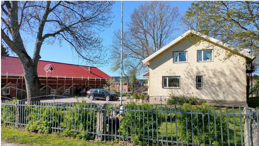
Kuva 42 Rekolan tilan nykyinen päärakennus on rakennettu 1960-luvulla. Kuvan vasemmassa laidassa näkyy Rekolan tilan vanha kavinavetta, todennäköisesti 1900-luvun alusta. Vuoden 2024 inventoinnin maastokäynnin aikaan navetan vesikatetta oltiin kunnostamassa.
