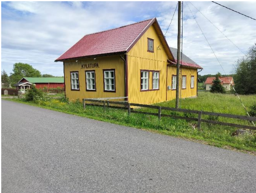
Kuva 2. Kaava-alueen rakennuskantaa (kuvassa Kylätupa) Mannilan kylässä. 20.6.2024.
