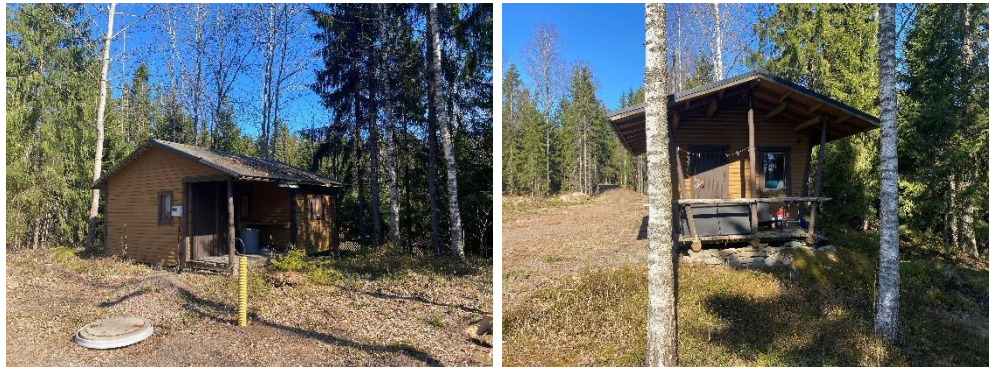
Taloussrakennukset suunnittelualan kiinteistöllä.
