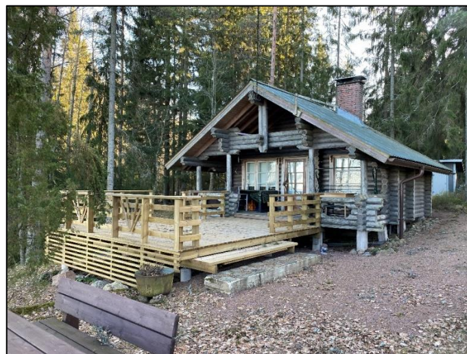
Vapaa-ajan asuinrakennus kiinteistöllä 50-416-23-0 Kotokolo.
