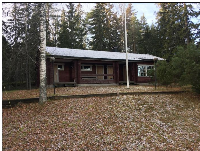
Apetit Oy:n käytössä oleva saunarakennus suunnittelualueen koillisosassa.
