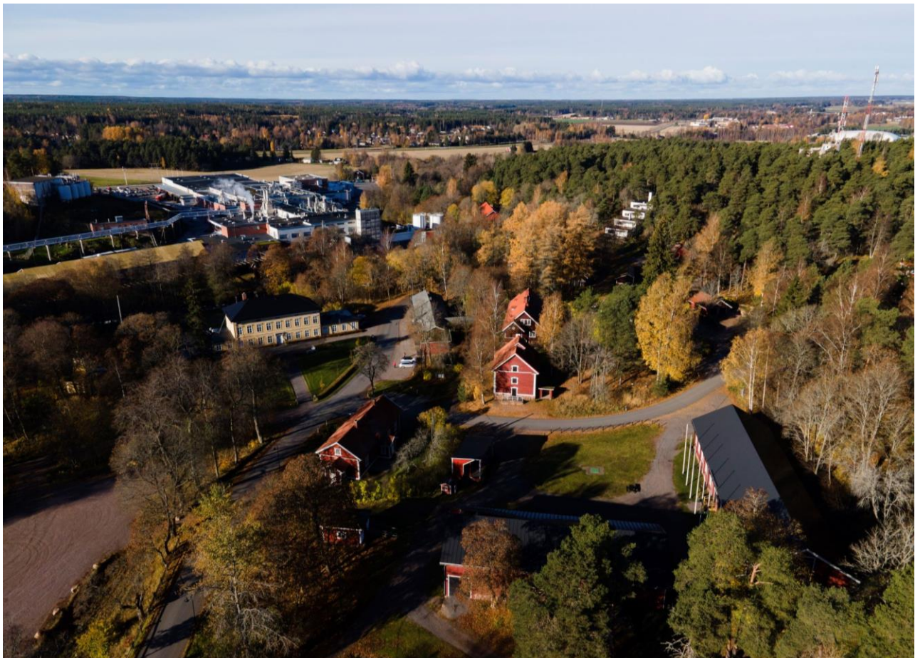
Kauttuan ruukin alue Eurassa on maakunnallisesti ja valtakunnallisesti merkittävää rakennettua kulttuuriympäristöä. Kuva: Tomi Glad
